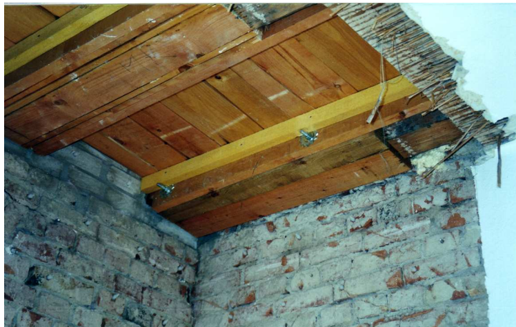
Bild 7: der Streichbalken (18 x 22 cm) wird lediglich durch das 3,5 x 22 cm Seitenholz getragen.
