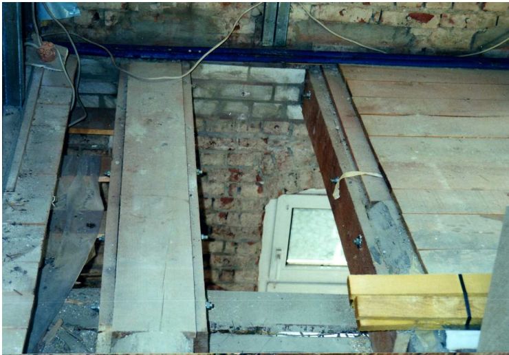
Bild 2: Ansicht der Deckenbalken mit den Seitenhölzern und dem Füllholz von oben
