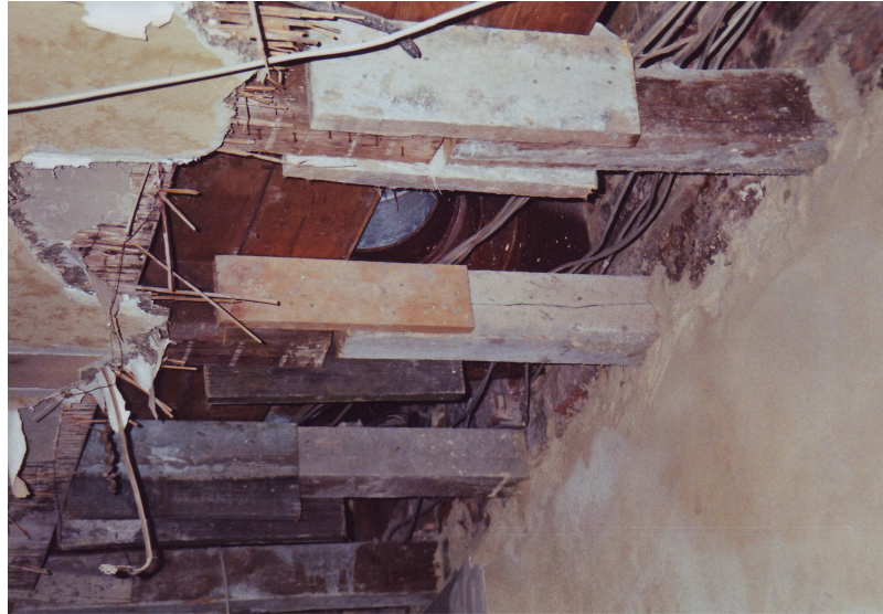
Bild 1: Während eines Umbaus wurde dieser Deckenteil geöffnet und diese angestückelten Deckenbalken wurden sichtbar.
