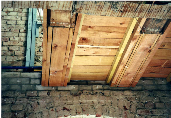
Bild 3: Das Lagerholz über dem gemauerten Fenstersturz wurde entfernt und durch eine Schicht Kalksandsteine ersetzt
